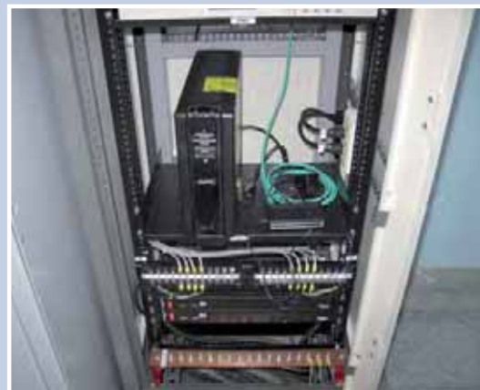
PMU Instalado
