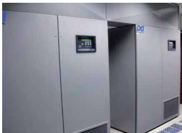
Equipos de aire acondicionado de Precisión
